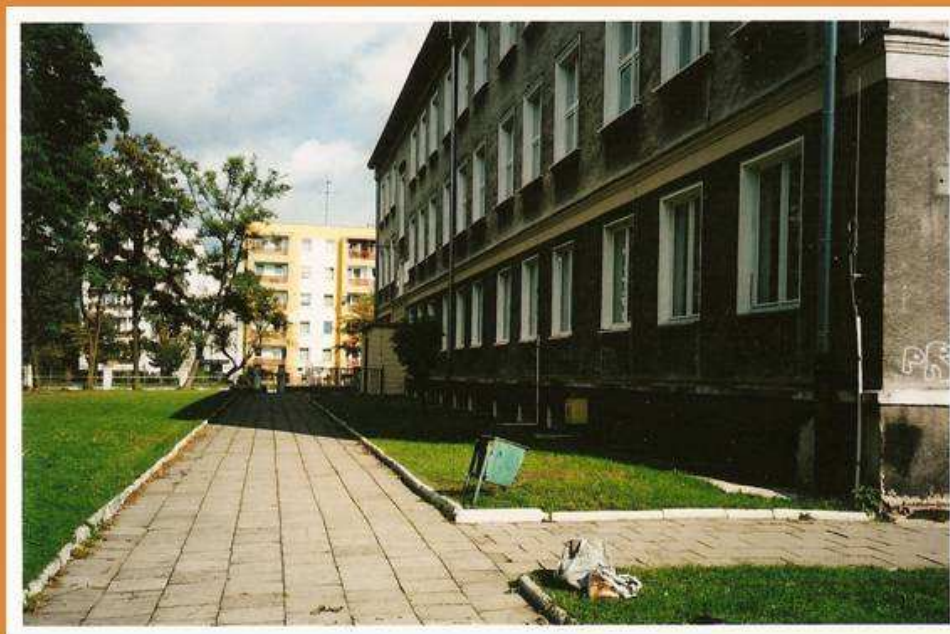
Rys. 2. Wejście do szkoły – widok przed zasadzeniem roślin
